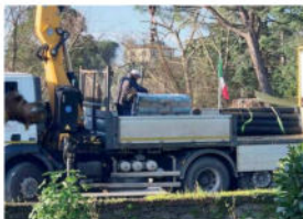
Lavori alla base dell'argine del Rio Torto. In alto: la strada chiusa e i lavori di manutenzione. In basso: la strada chiusa e i lavori di manutenzione.
