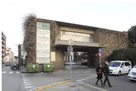
L'area ex Lazzi versa in uno stato di abbandono, denunciato dai residenti
