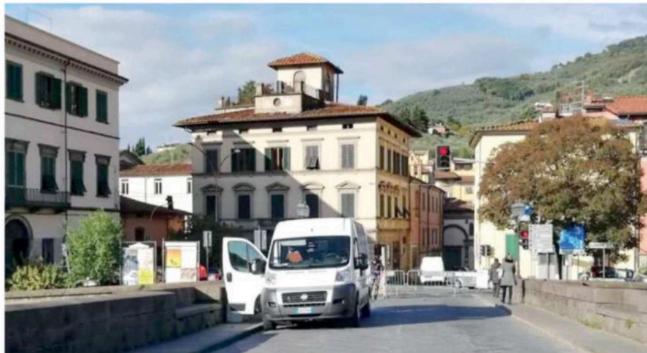
La chiusura nel 2020 del ponte del Duomo per le verifiche alla struttura da parte della Provincia di Pistoia
